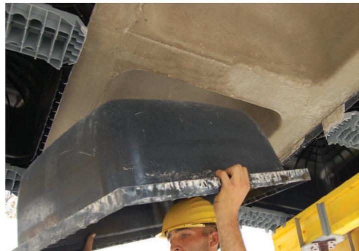
**1** Transcurridos 6-7 días del hormigonado, es posible iniciar el desencofrado del sistema SKYDOME, quitando en secuencia los puntales, las vigas amarillas, los bloques de ABS y las viguetas de ABS. La operación se efectúa siempre empezando desde abajo, trabajando con total seguridad.
