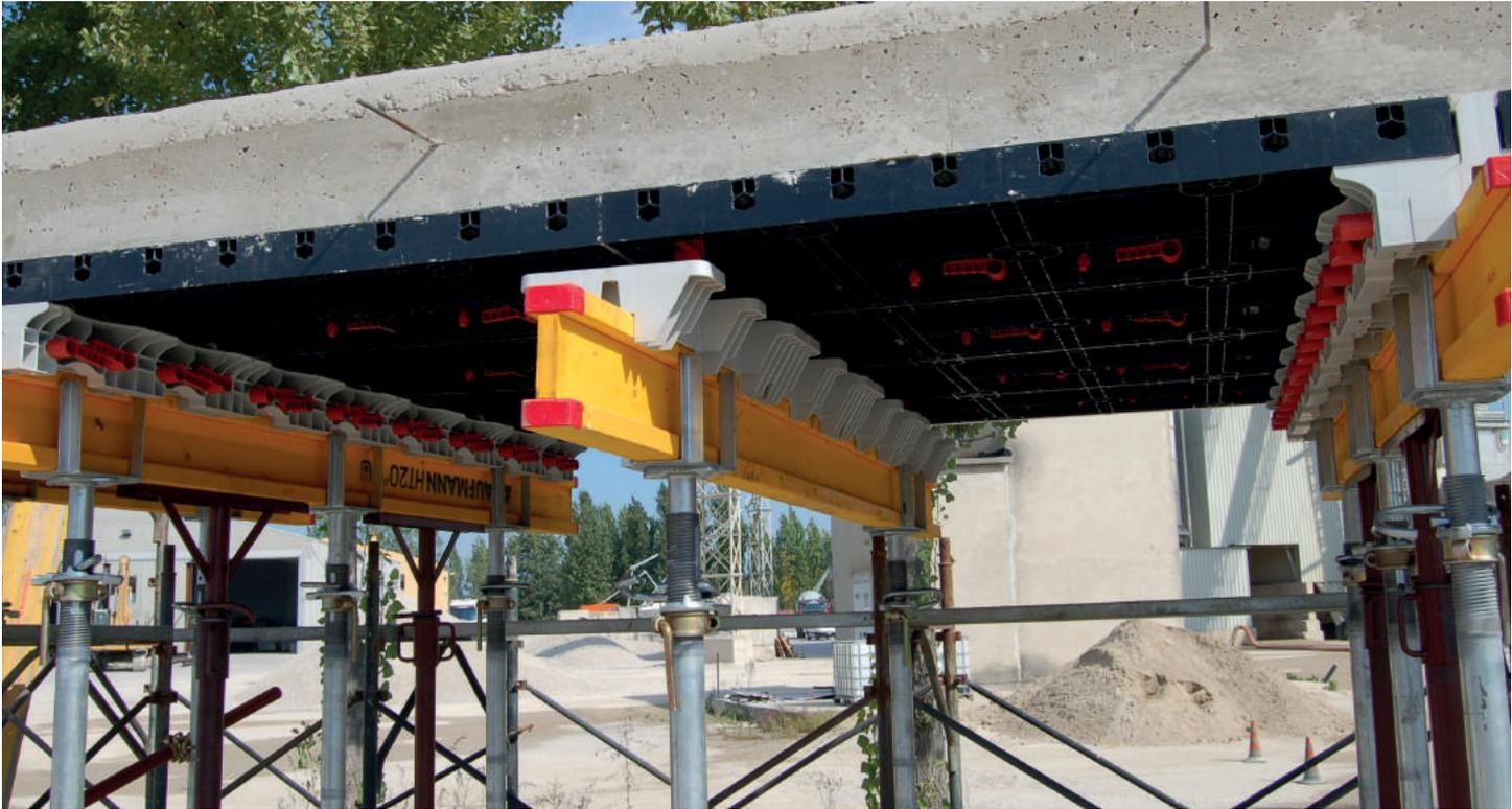
Sistema de casetones recuperables para la formación de superficies de colocación para la realización de forjados.
