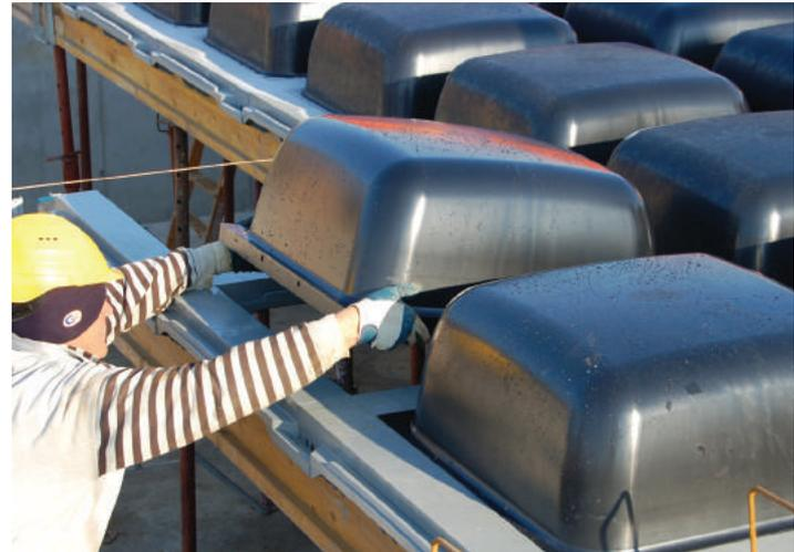
**1** Una vez creado el sistema de sostén (puntales + vigas amarillas), se colocan las viguetas de ABS y los bloques de ABS a fin de crear un retículo regular para albergar las cúpulas. A medida que se crea el retículo, se colocan también las cúpulas.
